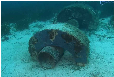
Imagen 11. Extremo final tramo difusor a retirar (40 m, cota -20,3 m)
