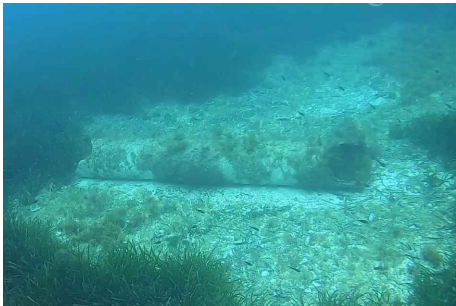
Imagen 12. Fragmento de conducción a retirar (20 m en total, cota -13 m)
